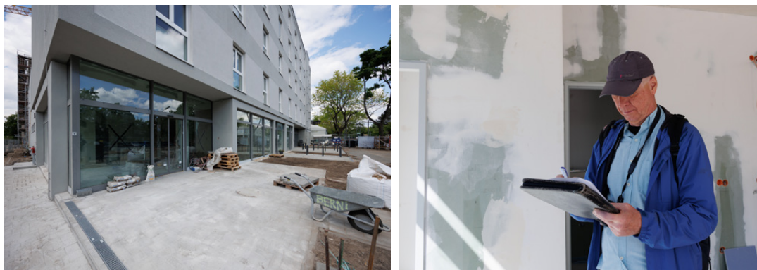
Auf der Terrasse vor der künftigen Bäckerei Steinecke wird es 16 Sitzplätze geben. Bei unserem Besuch (hier Wolf D. Wust) wird innen und außen noch gewerkelt. Im Juli sollen die Arbeiten abgeschlossen sein.
