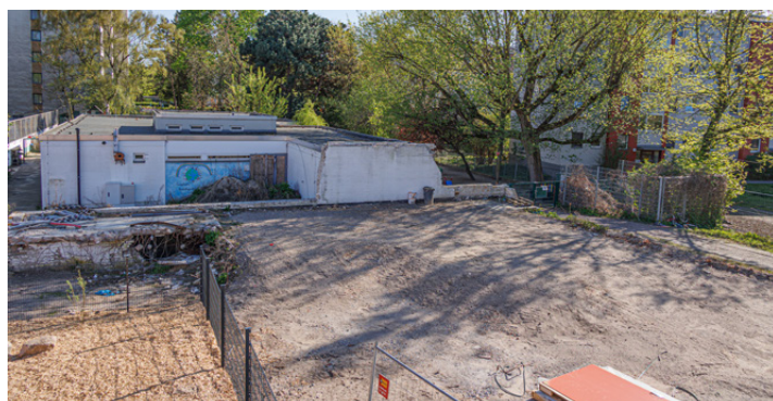
Neben der Kita wird weiter gebaut: Im neuen Zentrum für soziale Dienste entstehen noch eine Tagespflege, eine Wohngemeinschaft für Demenzzranke, Seniorenwohnungen sowie eine Wohngemeinschaft für Azubis der Diakonie. Geplant ist, dass die Bauarbeiten im Herbst beginnen und nach drei Jahren abgeschlossen werden sollen.
