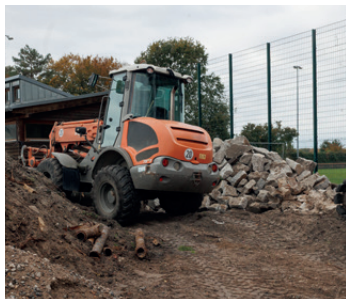
Baustelle am Sportplatz Heckerdamm 204
