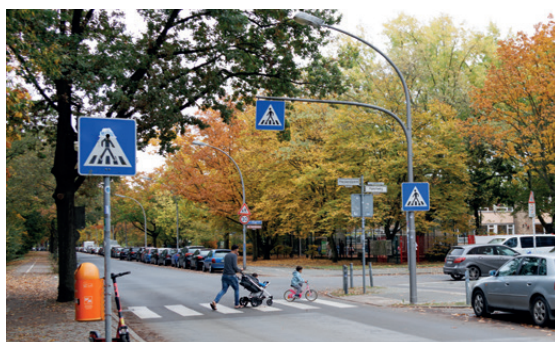
Hier an der Einmündung zum Halemweg wurde eine Gehwegvorstreckung gebaut und ein Fußgängerüberweg eingerichtet.
