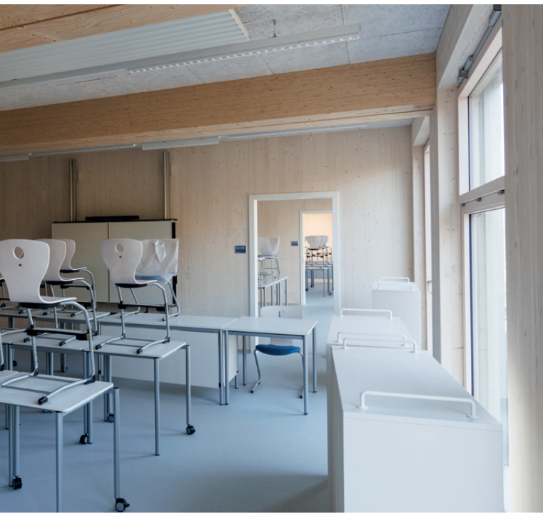
Blick in einen Klassenraum und in den dahinter liegenden Teilungsraum. Schallschutz-Elemente und Heizkörper befinden sich übrigens an der Decke. Die Jalousien werden elektronisch gesteuert.
