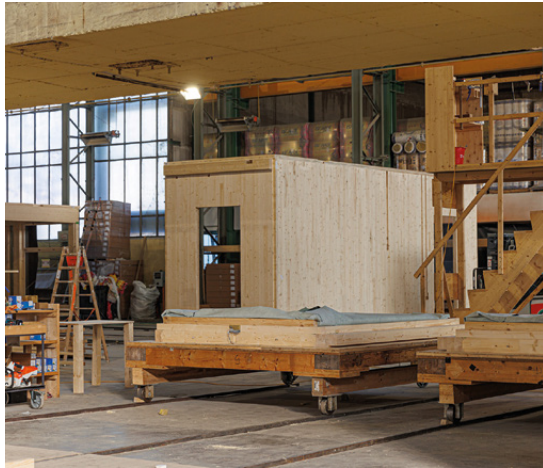
In der Werkhalle werden die Module auf Schienen zur nächsten Arbeitsstation geschoben.
